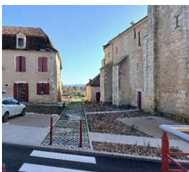
Création de voies piétonnes
