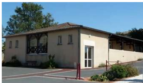
La salle des fêtes de St Barthélémy de Bellegarde a été rénovée en vue d'améliorer son efficacité énergétique
